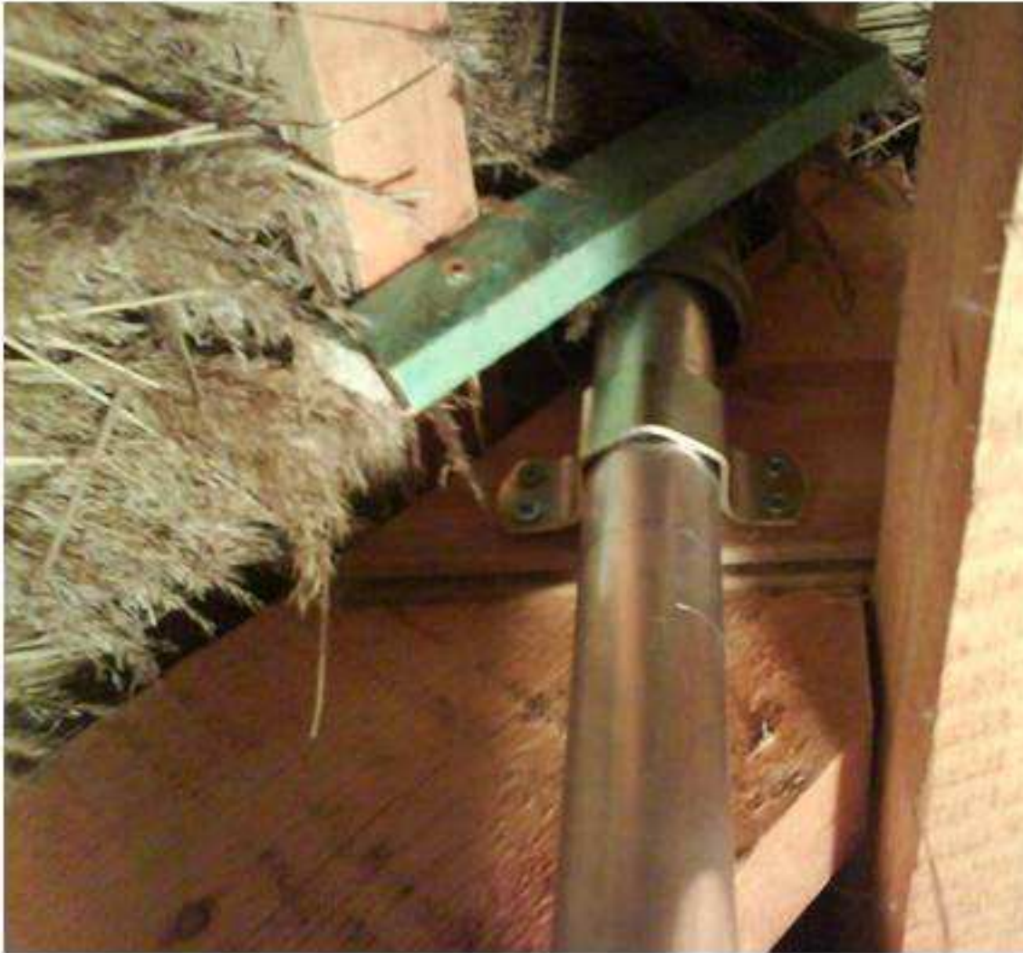
Befestigung im Dachstuhl
