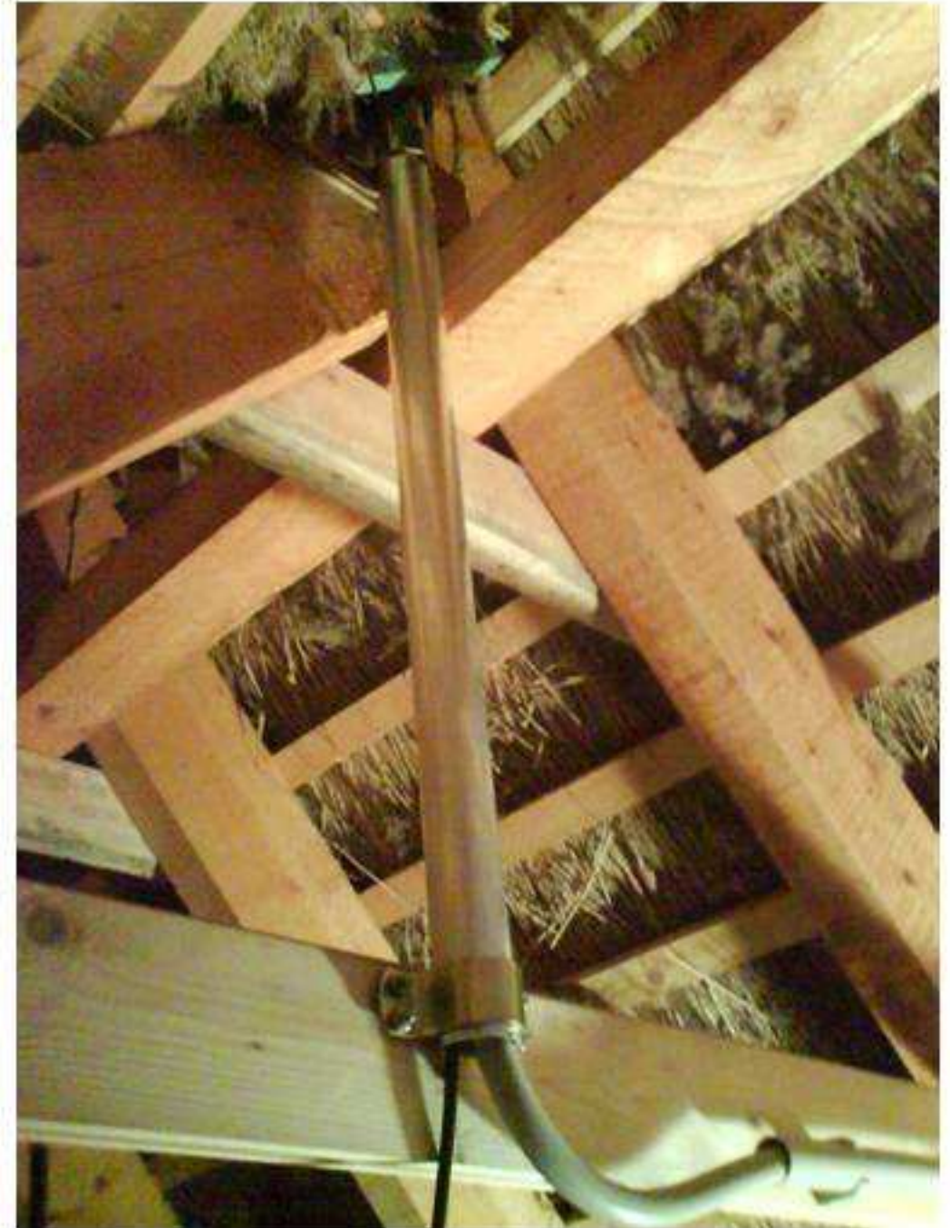
Stützrohr im Dachstuhl
